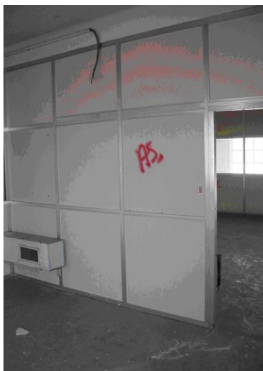
'Glasal' of 'Cloisal'-platen: binnenwanden van een kantoor
