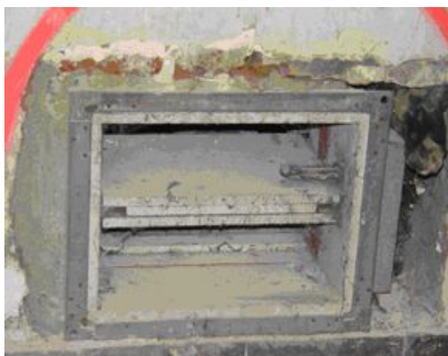
Brandwerende klep, aan de binnenkant met plaatmateriaal van het type 'Pical' bekleed. Het afsluitplaatje bestaat zelf ook dit plaatmateriaal.
