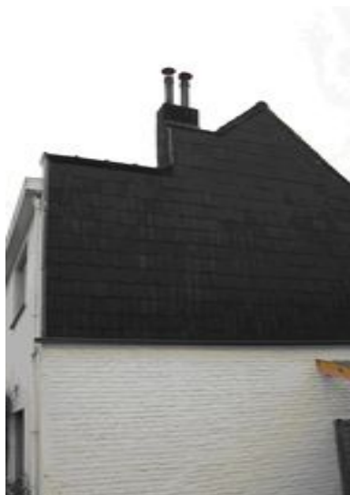
Zwarte leistenen in asbestcement op de puntgevel van een woning en schoorstenen in asbestcement
