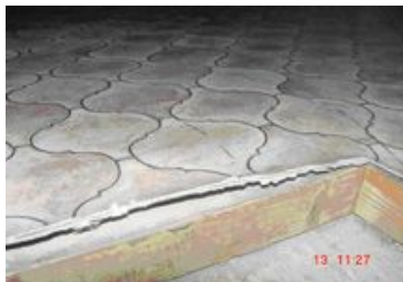
Balatum met een vrij kenmerkend motief, waarvan de gekartonneerde onderlaag licht gebonden asbestvezels bevat
