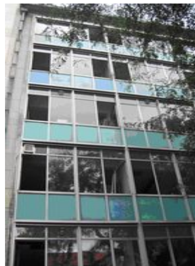
Panelen in asbestcement van het type 'Glasal' als steunmuur in een gevel (blauwgroene externe afwerkingslaag)
