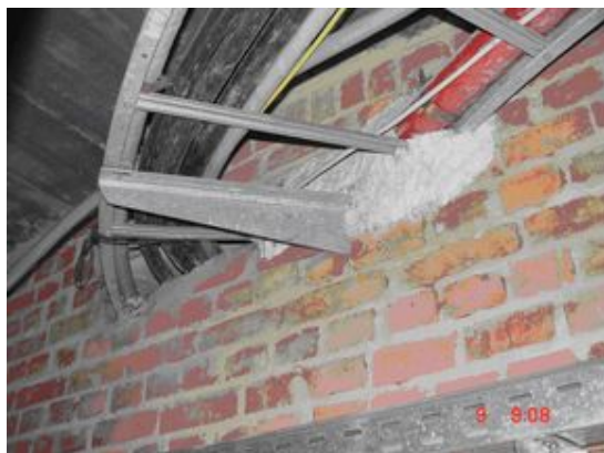
Spuitasbest met amosiet (grijs) met een buitenlaag als inkapseling (dikke verf) op een metalen steunbalk met « I » vorm. Opvallend is het gerimpelde oppervlak.
