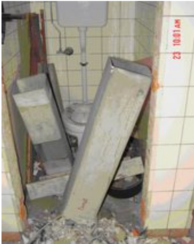
Verluchtungskokers in asbestcement (van sanitaire installaties)
