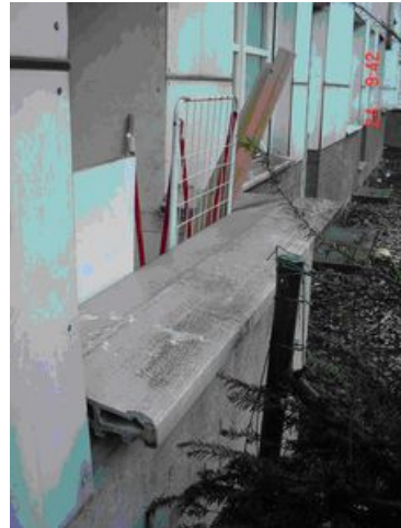
Muurbekleding in asbestcement (honingraatstructuur) en gevelplaten in asbestcement van het type 'Glasal' (witte externe afwerkingslaag)
