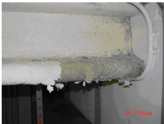
Spuitasbest met amosiet (grijs) met een buitenlaag als inkapseling (dikke verf) op een metalen steunbalk met « I » vorm. Opvallend is het gerimpelde oppervlak.
