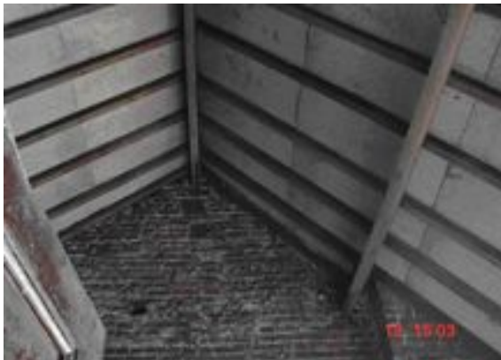
Dunne onderdakplaten van het type ‘menuiseriet’ (hier vuil roze, maar vaak gelig)
