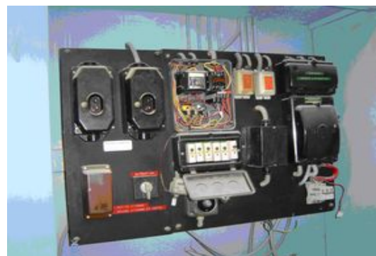
Zwarte elektrische wandplaat (venstertablet, dorpels en plinten kunnen van hetzelfde materiaal gemaakt zijn).
