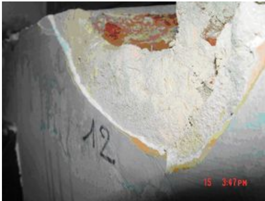
Dunne afwerkingslaag op muur in asbesthoudende pleister
