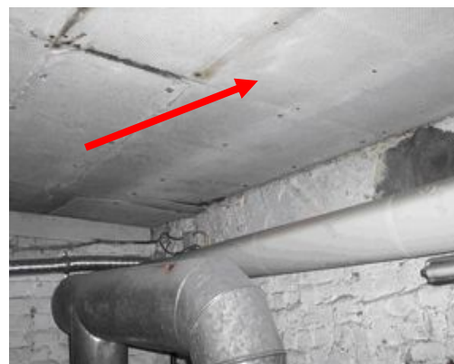
Rf valse plafondplaten van het type 'Pical' in een stookruimte (kenmerkende wafelstructuur)
