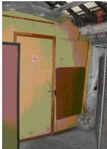
Wand bestaande uit dunne platen van het type ‘menuiseriet’
