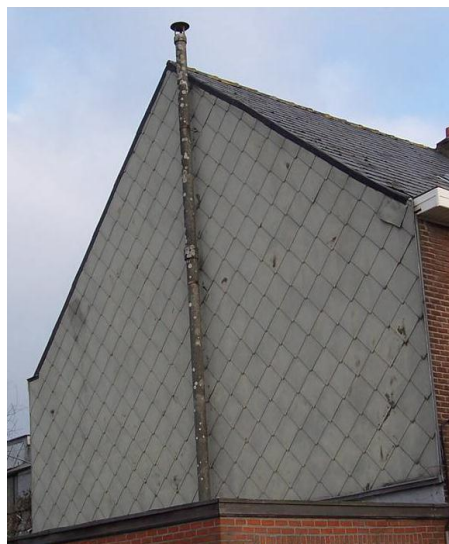
Dak, gevel en schouw in asbestcement
